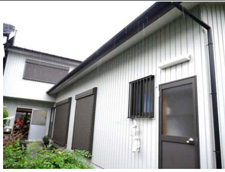
家屋外観(北側・手前:平屋、奥:2階建)
