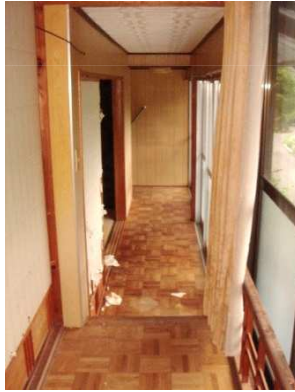
廊下 (2階・東側)
