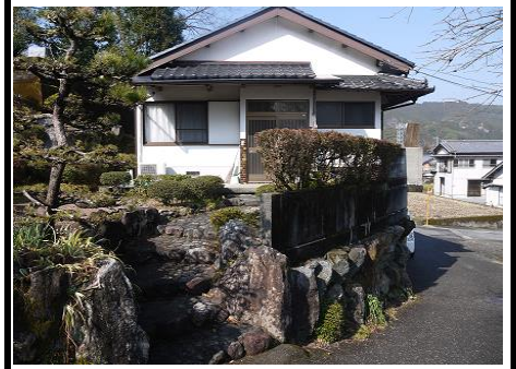
東側外観(玄関付近)
