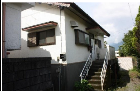
外観(北側 外階段・玄関)
