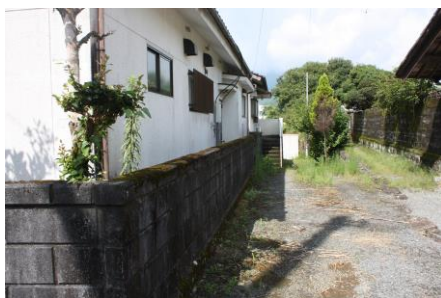
外観(北側 外階段・進入路)
