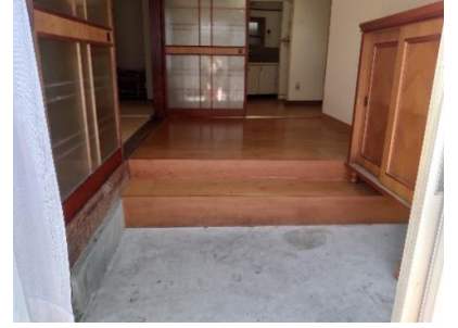
玄関(三和土・上り框・玄関ホール)
