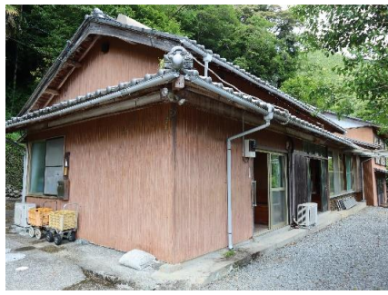
正面(西面から東面を見る)
