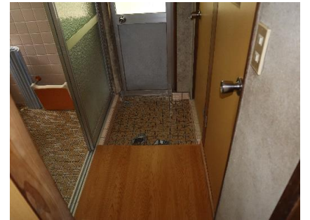
風呂・勝手口・トイレ
