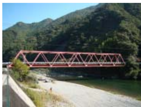
宮ヶ奈路一号橋 (昭和48年架設)
