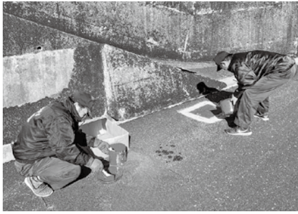
水利点検の様子
