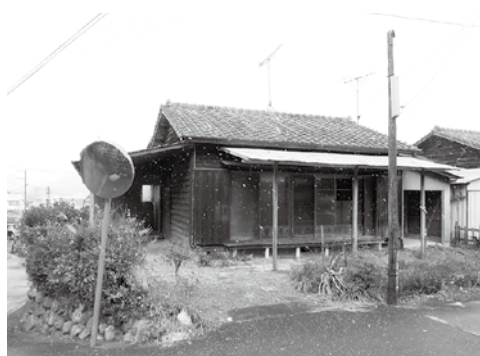
入居者への譲渡や空き住宅は解体している単独町営住宅（解体前の公園団地住宅）
