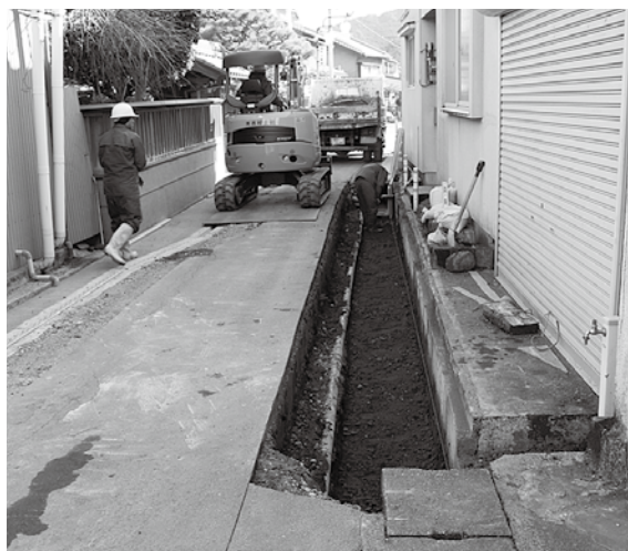
交付金で道路側溝が整備されている
