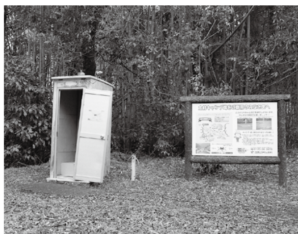
整備が急がれる本村キャンプ場トイレ
