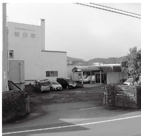
改修工事が予定されている春日荘
