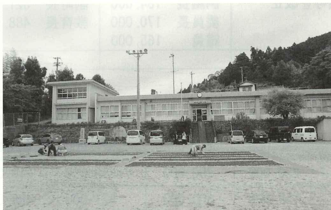
改修される横畠西部公民館(旧横畠小学校)
