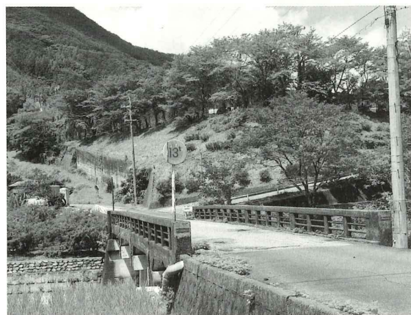
橋りょう補修設計を行う宮ノ谷橋（鎌井田）
