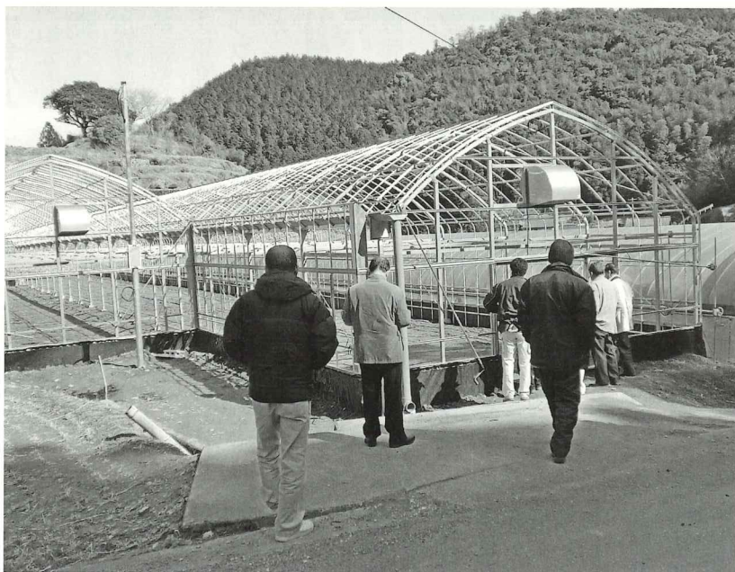
ニラ栽培に向けて整備が進む(山室)
