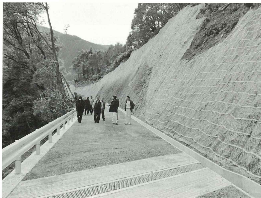
林道工事で山を生かす
