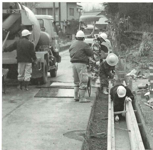
側溝工事で道がきれいになる
