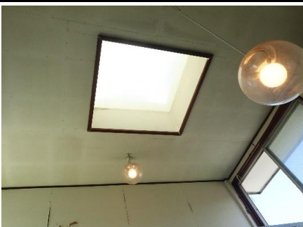
3F・ペントハウス天井
