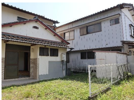
北西側 ・物置 ・ 駐車スペース
