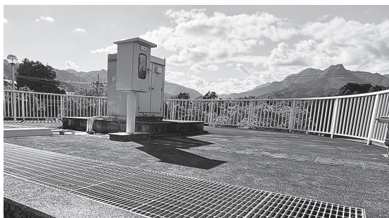
曝気装置(汚水に空気を送り込み、微生物を活性化させることで不純物を分解させる装置)(左)と横倉山(右)
