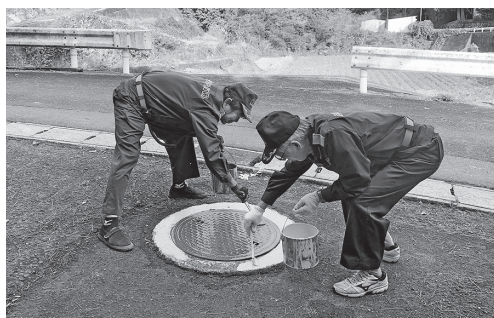
水利点検実施中の様子
